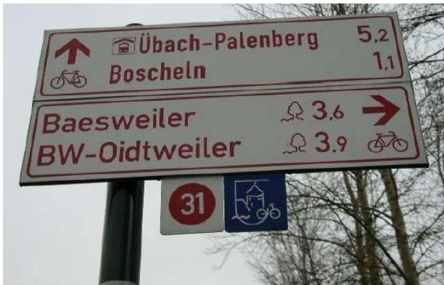
Abb. 3-9: Tabellenwegweiser mit Routeneinschüben
